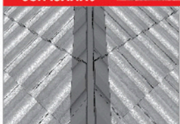
1 ติดตั้งกระเบื้องหลังคา และชุดอุปกรณ์ยึดครอบระบบแห้งให้เรียบร้อย โดยระดับหลังคาครอบควรติดตั้งให้ต่ำกว่าสันราง 1 ซม. เพราะจะทำให้ชายครอบสันโค้งบนหลังคากระเบื้อง
