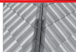
2 ติดแผ่นปิดสันหลังคา/ สันตะเข้ เอสซีจี โดยวางให้แนวเส้นด้านข้างของแผ่นปิดสันหลังคา/ สันตะเข้ เอสซีจี ทแยงขึ้น (ตามรูป) ยึดด้วยตะปูเกลียว ปลายส่วน เอสซีจี 32 มม.
