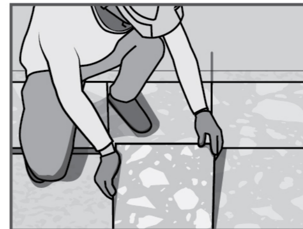
4.1 นำ TERRAZZO PROMPT ที่กาวยาซีเมนต์แล้ววางบนคอนกรีตที่ปรับระดับไว้แล้ว
