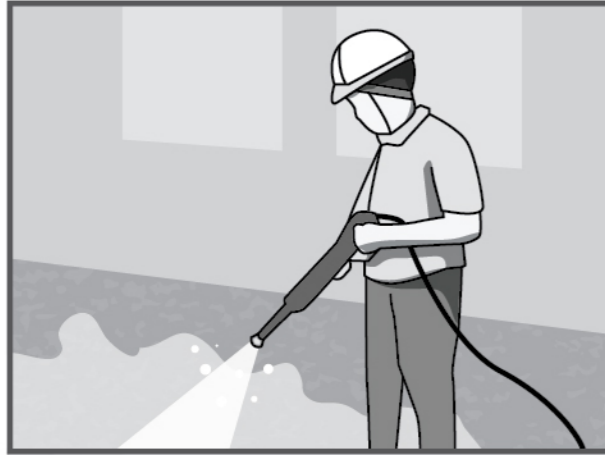
1.1 ล้างทำความสะอาดผิวคอนกรีตเดิม
