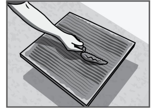
3.2 ใช้เกรียงหวี ร่อง 10 มม. ป้ายกาวยาซีเมนต์ที่ด้านหลังของแผ่นกระเบื้องรีดไปในทิศทางเดียวกันให้ทั่วทั้งแผ่น
