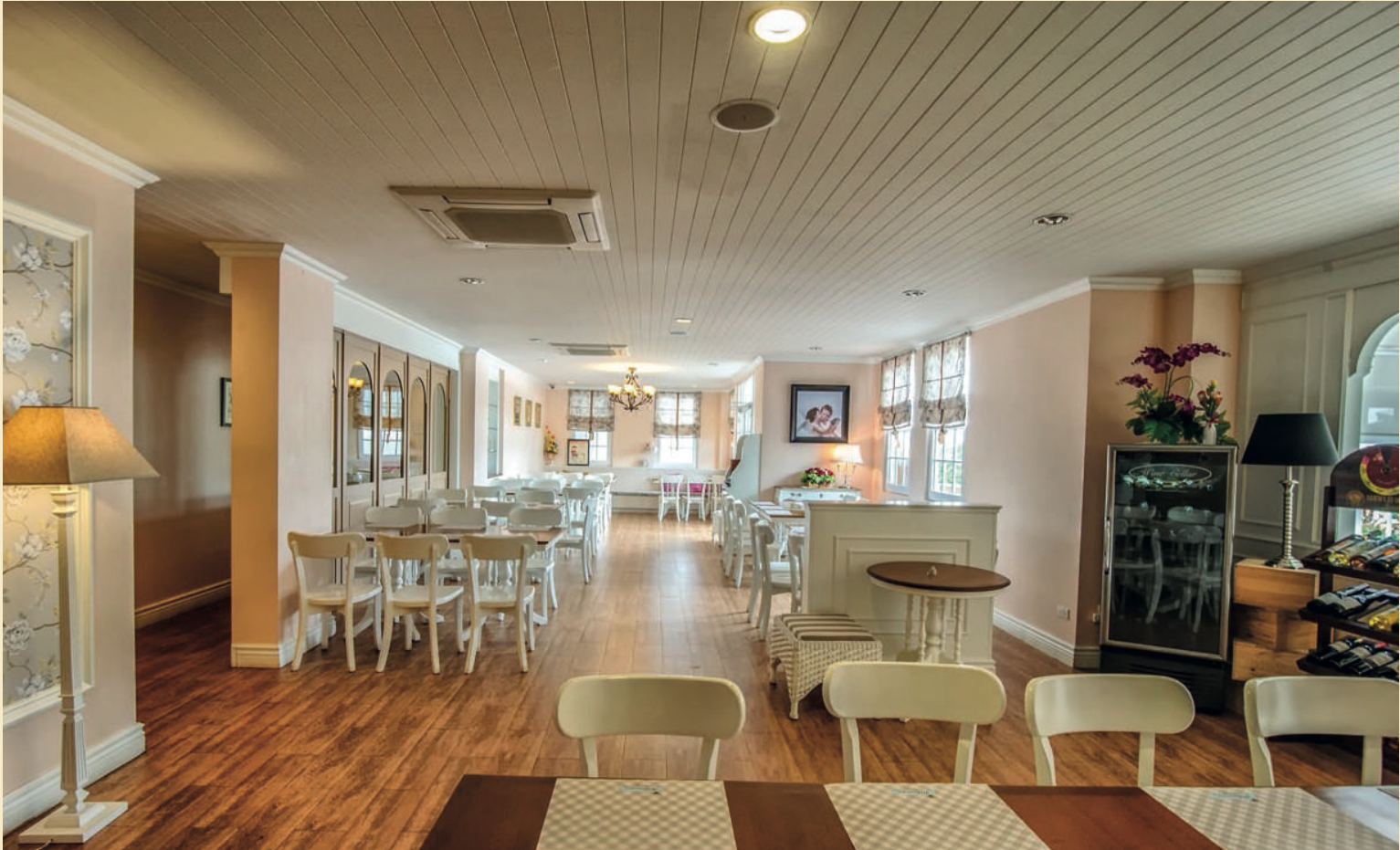
ตกแต่งฝ้าภายในด้วย ไม้ระแนง เอสซีจี สีซีเมนต์ ทากับด้วยสีน้ำอะคริลิกสีขาว ช่วยให้เพดานดูสวย สะอาดตา และลายเส้นที่ช่วยเสริมสร้างให้เพดานดูมีมิติมากขึ้น สถานที่ : ร้านจิวเวลรี่ หัวหิน จ.ประจวบคีรีขันธ์
